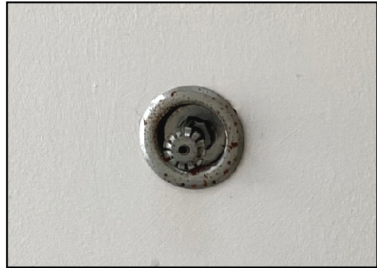
ภาพที่ 1-21 ระบบจ่ายน้ำอัตโนมัติ
